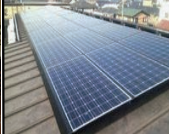
太陽光発電システム
