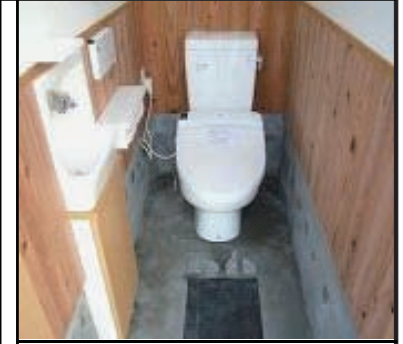
トイレ工事(木&塗り壁)
