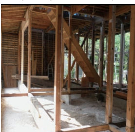
基礎・柱・梁・屋根
